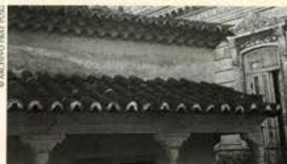
Vista general y detalle del balcón de esquina con tejadillo y alero en tejaroz.
