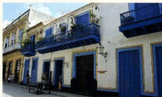
Fachada de la casa de Obispo 117-119, Habana Vieja.
