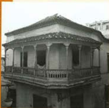
Vista general y detalle del balcón de esquina con tejadillo y alero en tejaroz.
