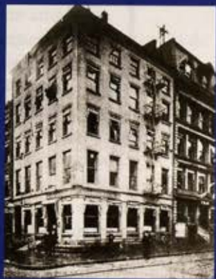
Fachada del edificio donde radicaba la oficina de José Martí, en 120 Front Street, Nueva York.
